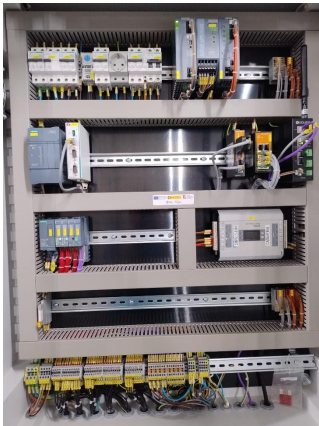
Figura 1. Instalación de armario eléctrico y telecomunicaciones para exportación de datos de caudal, presión y nivel a los sistemas de información central.
